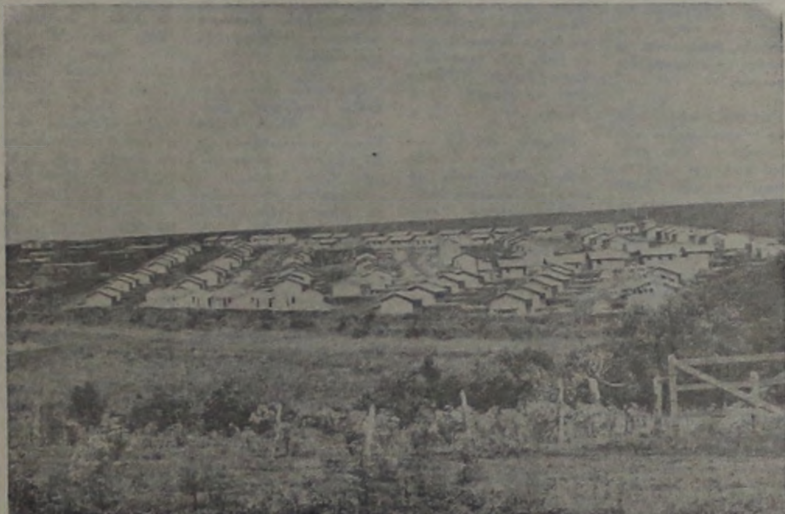
MAIS 80 CASAS SERÃO CONSTRUÍDAS NESTE NÚCLEO, EM JANEIRO
