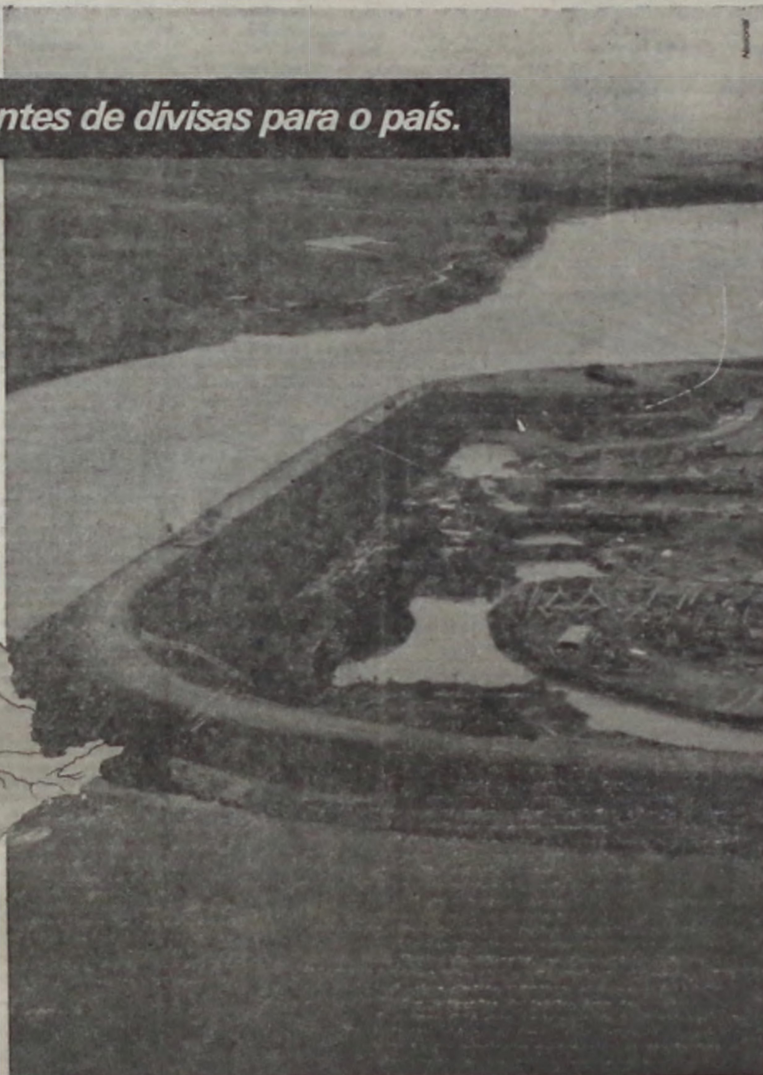
Obras da ensecadeira da Usina Nova Avanhandava, cuja primeira unidade entrará em operação em novembro de 1982.
