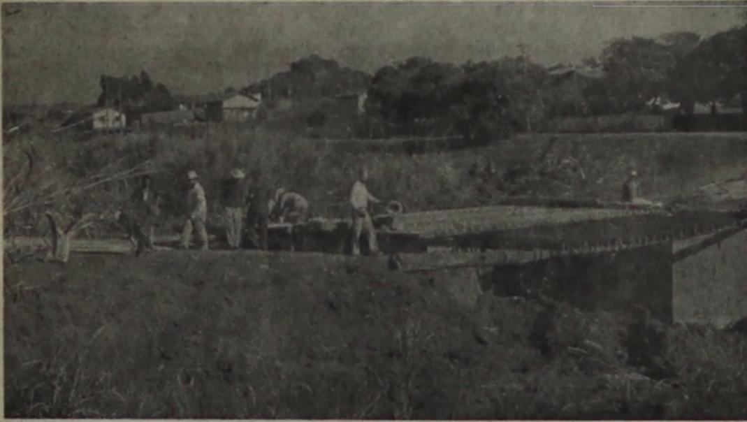
O setor de obras da Prefeitura já colocou a estrutura metálica da ponte que ligará o bairro cachoeirinha à área central da cidade. Na terça-feira será feita a camada de concreto para o leito carroçável e as cabeceiras da ponte, que se destina a transpor o rio
