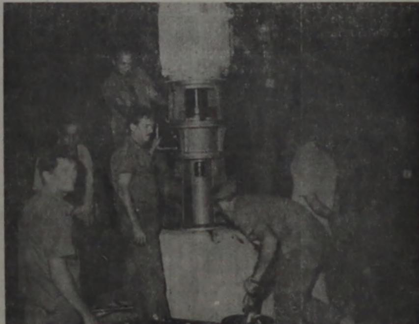
Parte externa da bomba - motor e comando - tudo funcionando com a garantia dos fabricantes (Bombas Esco - Embú, SP). A conclusão da instalação requereu trabalhos até altas horas da noite. Daqui, até o ponto da captação, são 10 toneladas de equipamentos, mais 5 toneladas de água na tubulação.
