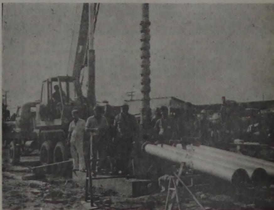
Detalhe da implantação da bomba de sucção que fica a uma profundidade de 132 metros para a captação da água, através de uma tubulação de 6 polegadas.
