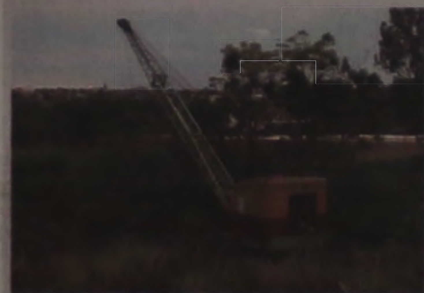
Draga inicia desassoreamento do rio Lençóis na Vila Repke.
