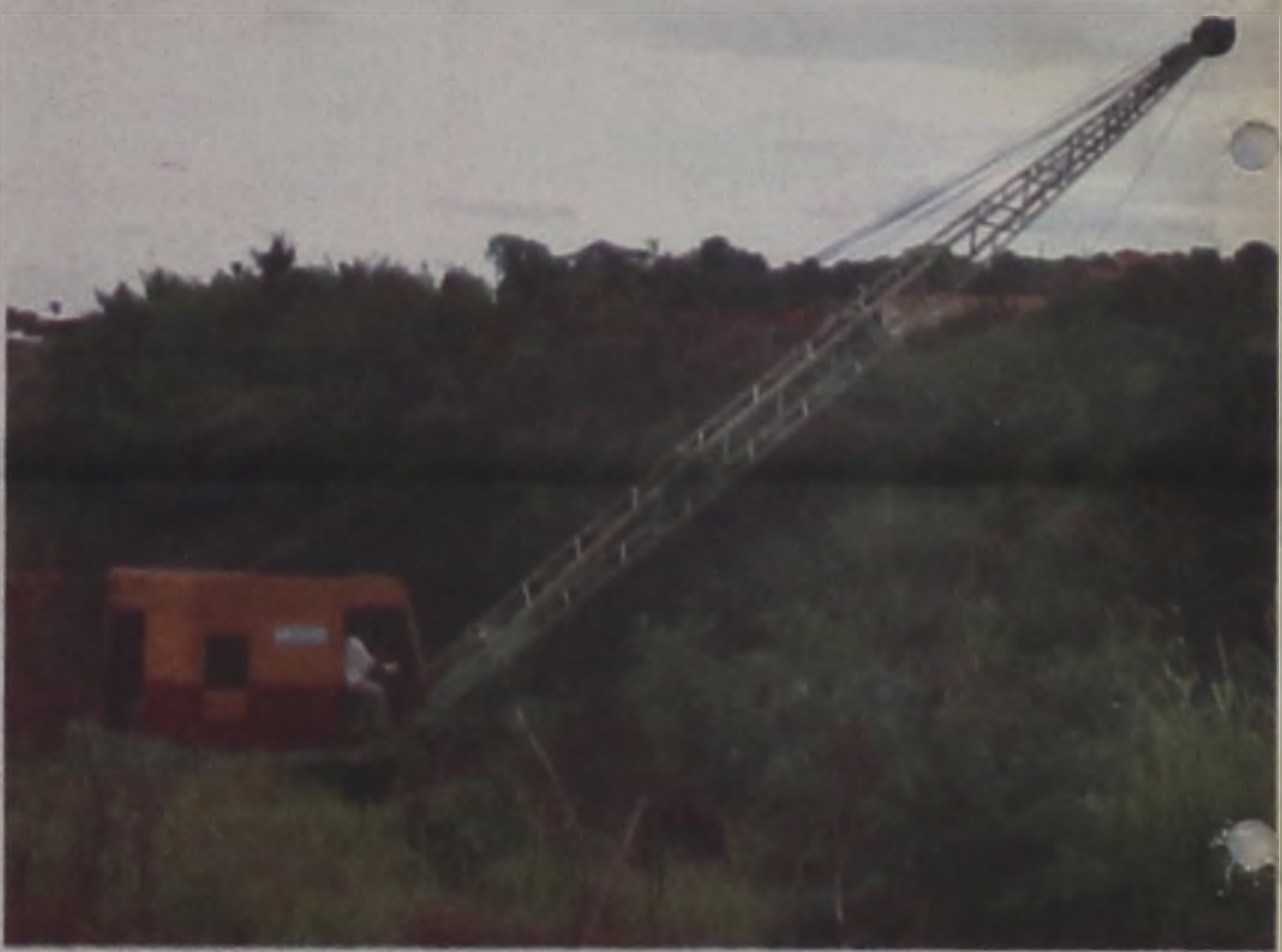
Draga realizando serviço de desassoreamento no rio Lençóis
