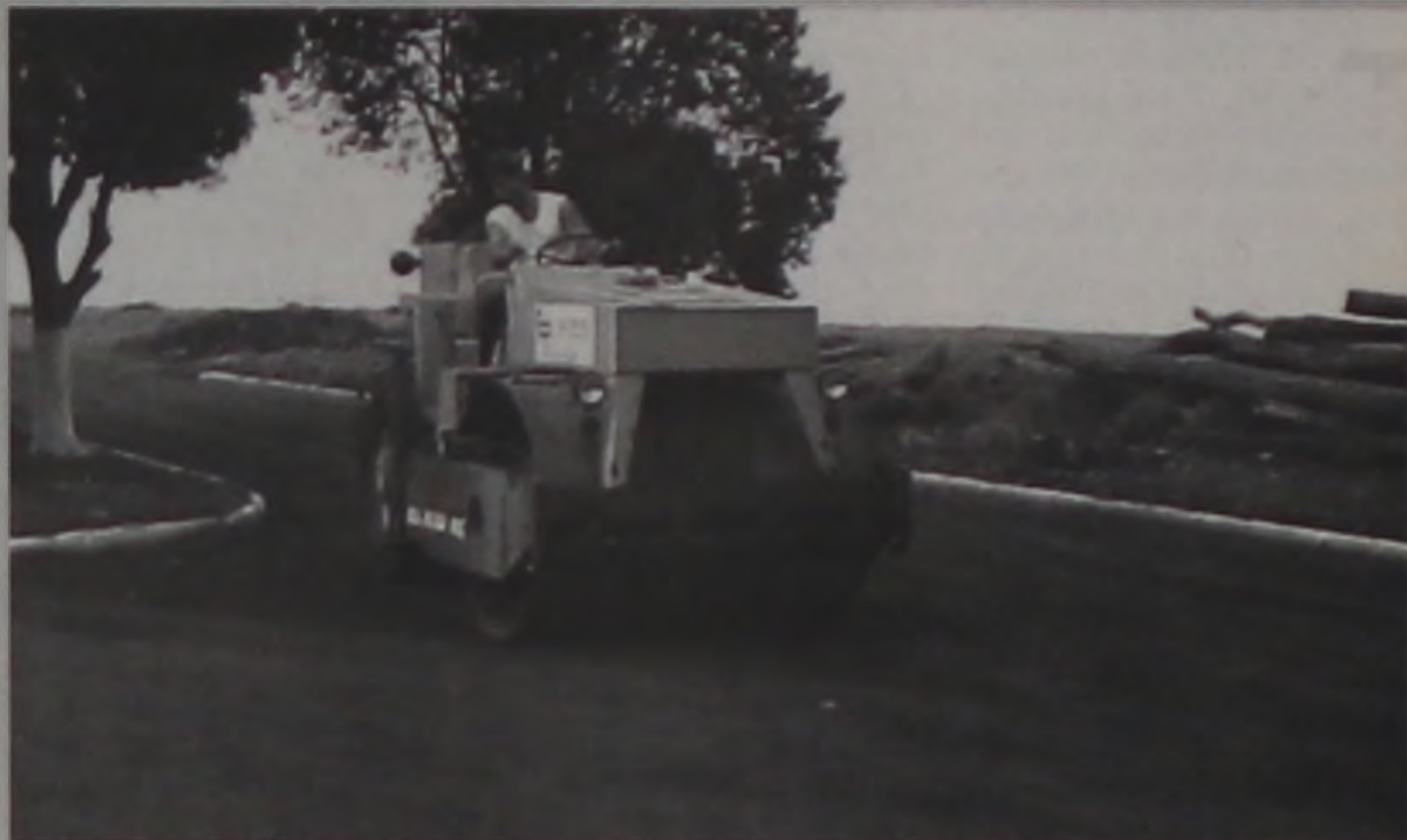
Pavimentação asfáltica em Alfredo Guedes
