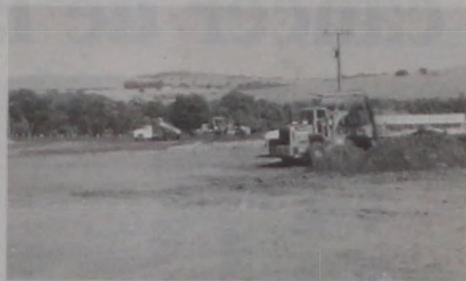
Local onde está sendo feito a terraplanagem para as serrarias
