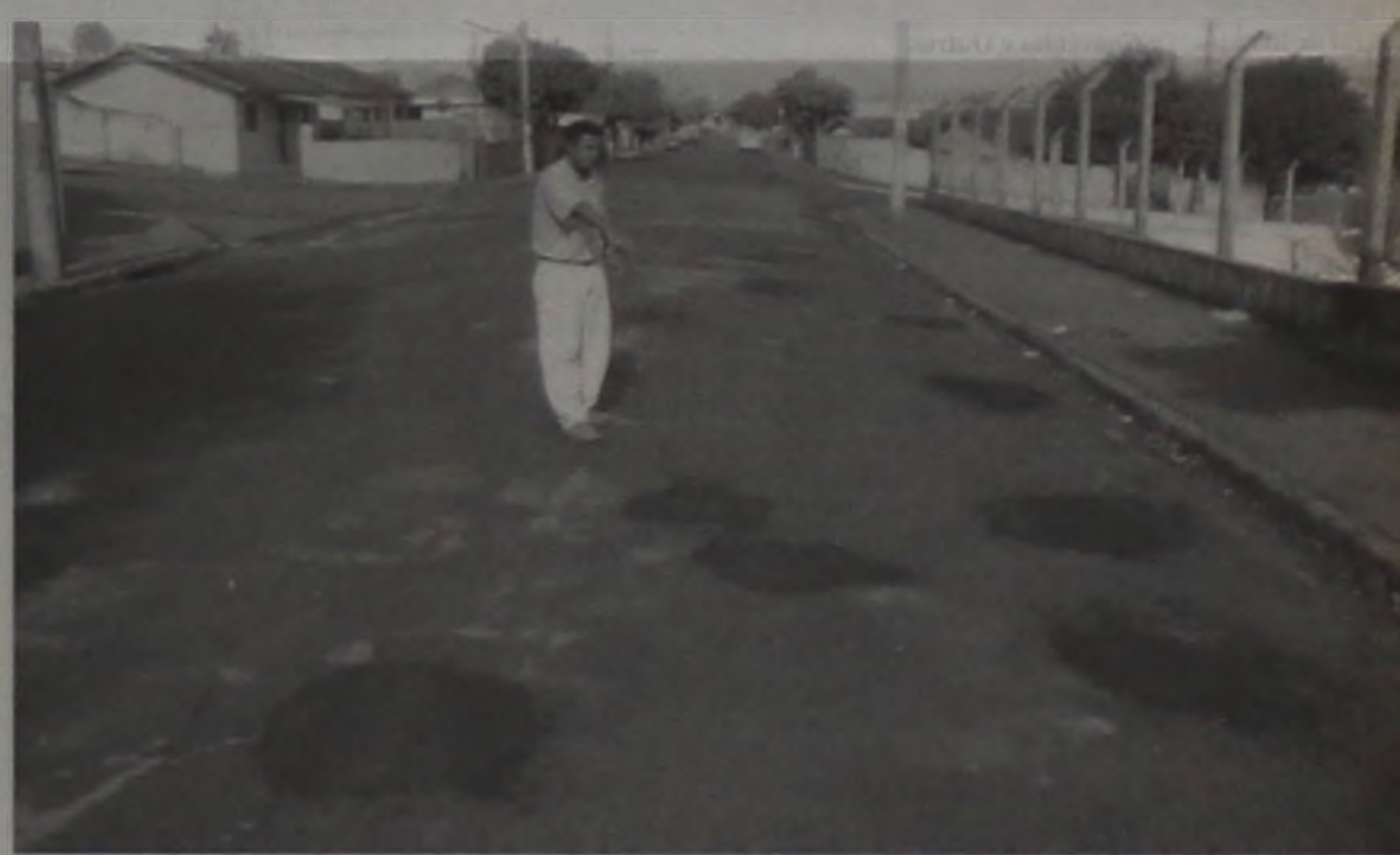
Manezinho acompanha os trabalhos da Operação Tapa-buracos na Cecap I
