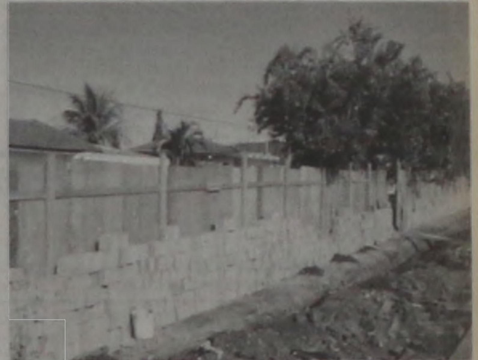
Construção do muro na rua Cel. Joaquim Anselmo Martins
