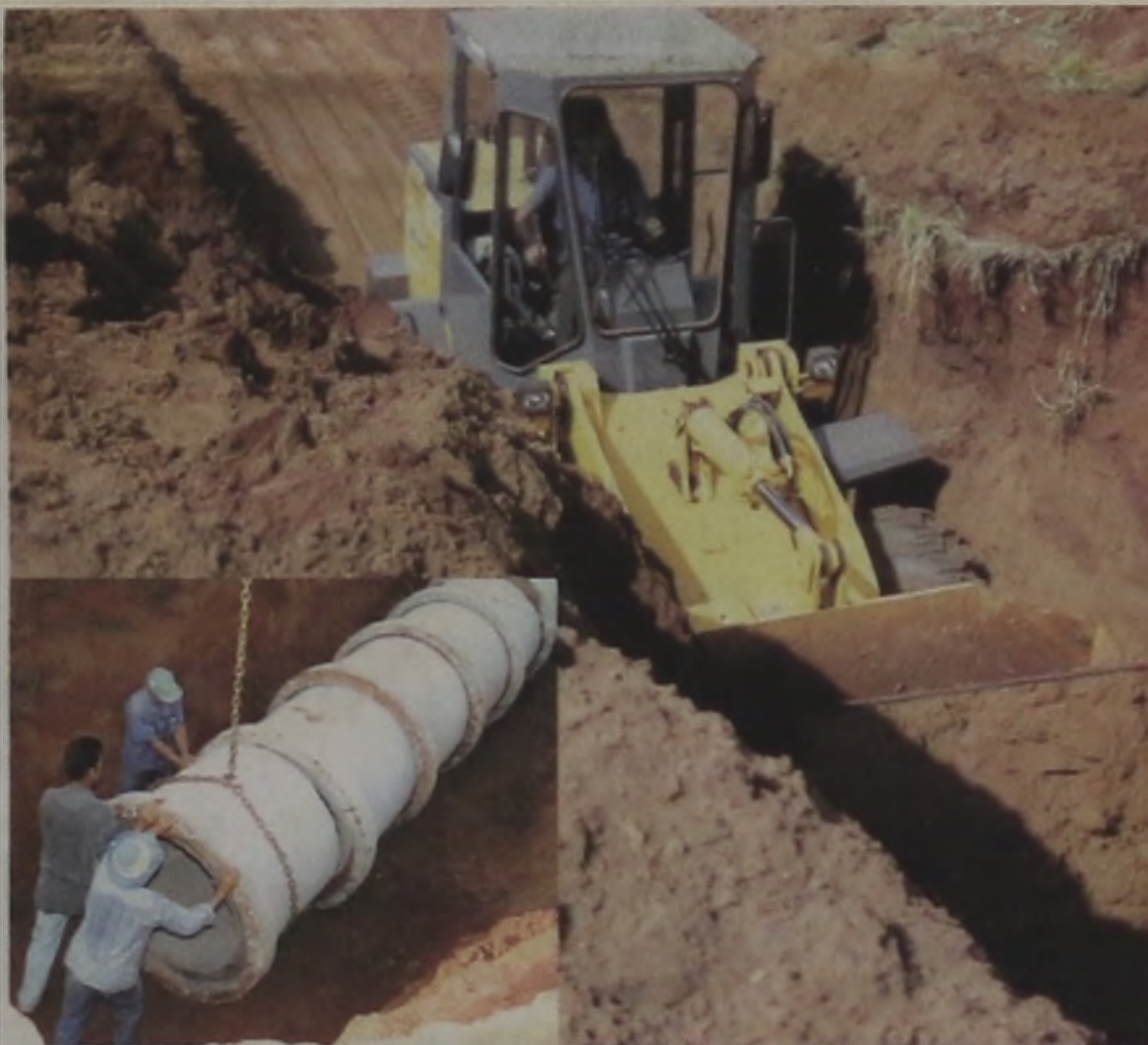
Máquinas da Prefeitura trabalharam durante a semana no Distrito Industrial
