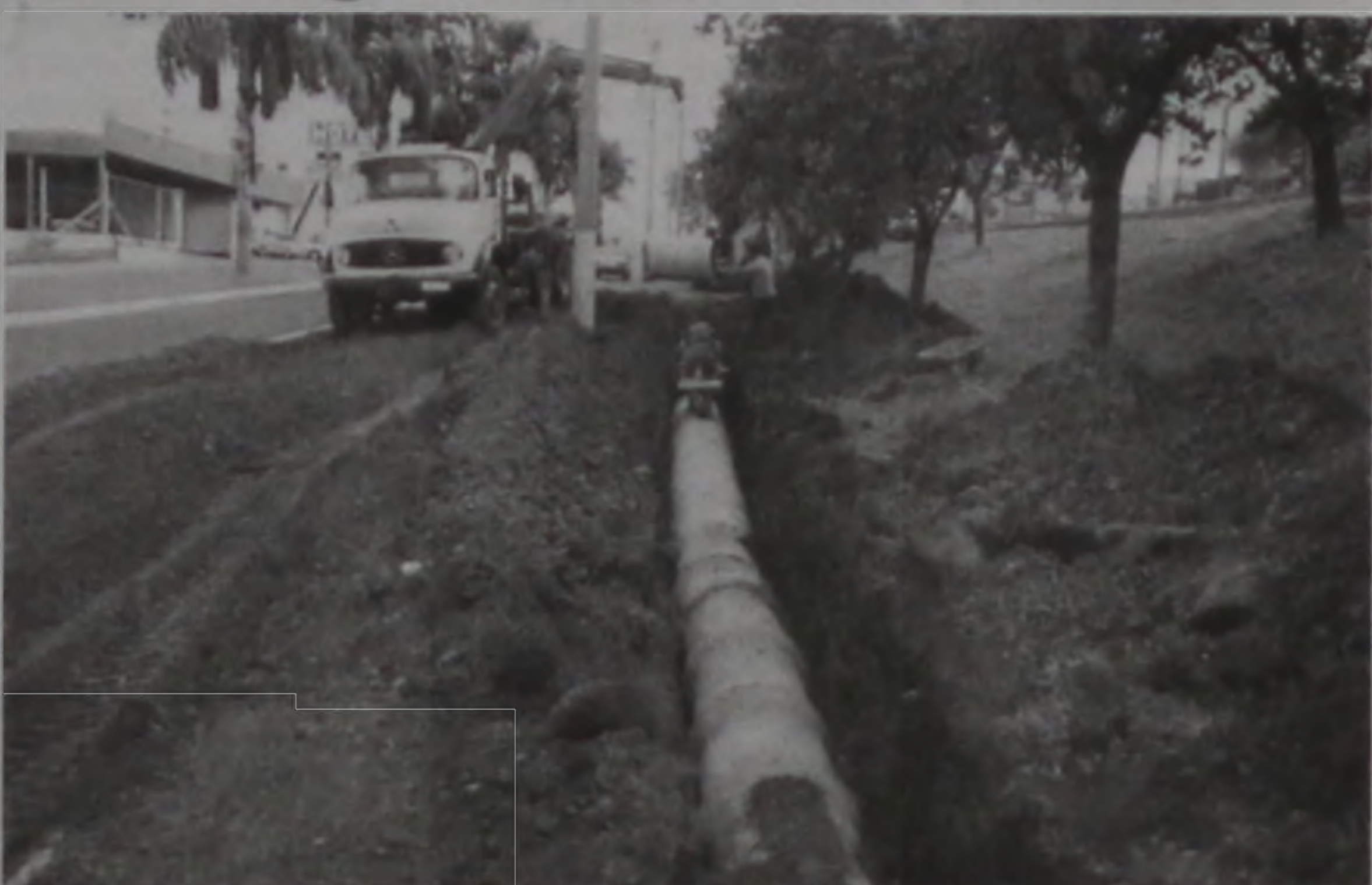
Equipes da prefeitura trabalham na implantação de galerias na Av. João Paulo II
