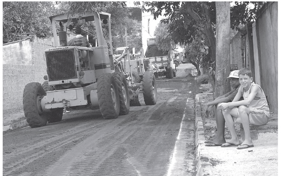
Júlio Ferrari recebe 6,6 mil metros quadrados de asfalto em seis ruas
