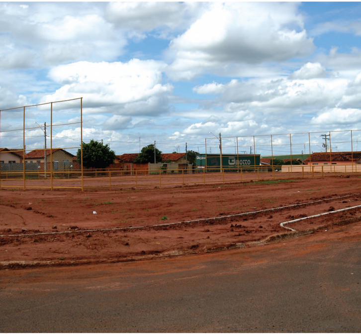
Área no acesso ao Jardim do Caju onde está sendo feita a obra
