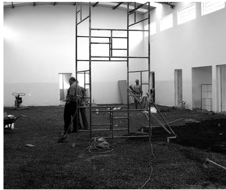
Obra da creche no conjunto Júlio Ferrari, retomada em março
