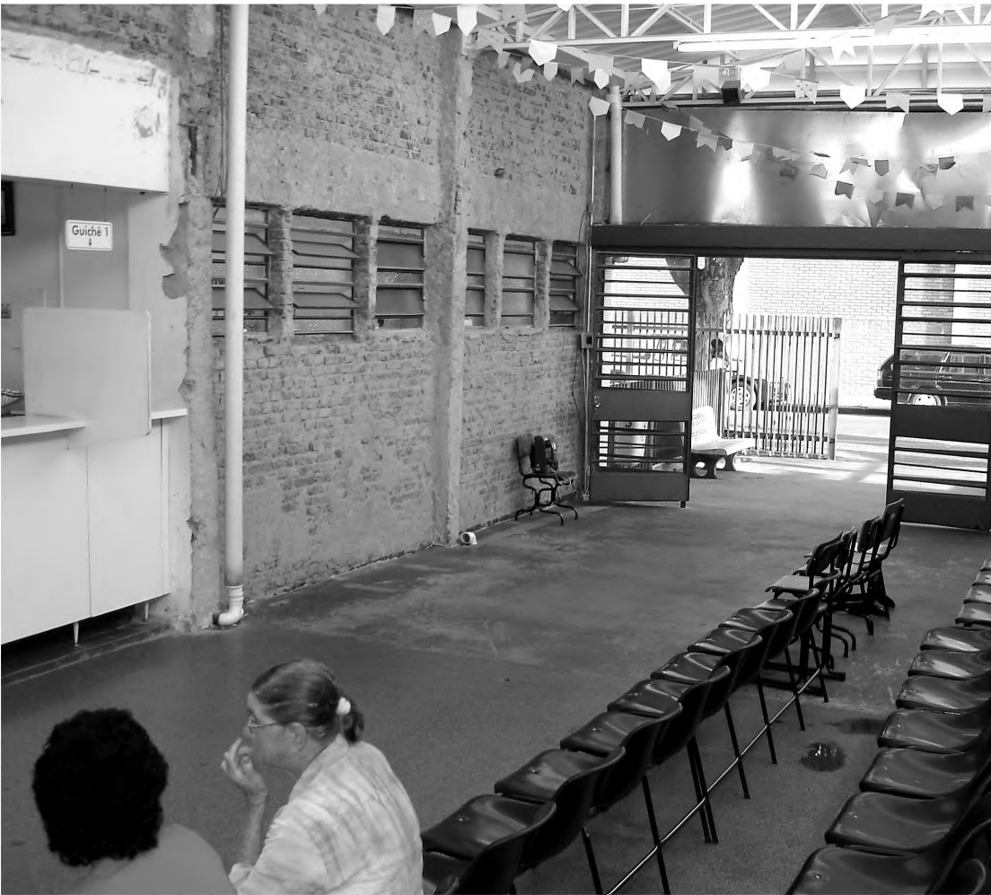
Interior do Ambulatório de Especialidades, na avenida Brasil, que está passando por reforma
