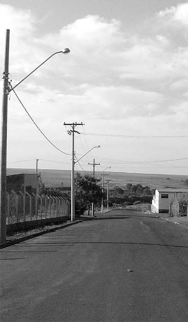
Rua Virgílio Enei, no distrito industrial, ganhou iluminação
