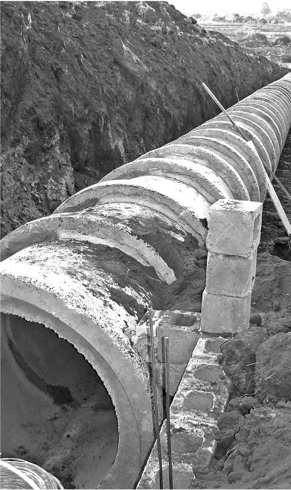
Operários trabalham na colocação de tubos na galeria que está sendo feita para captar águas da chuva
