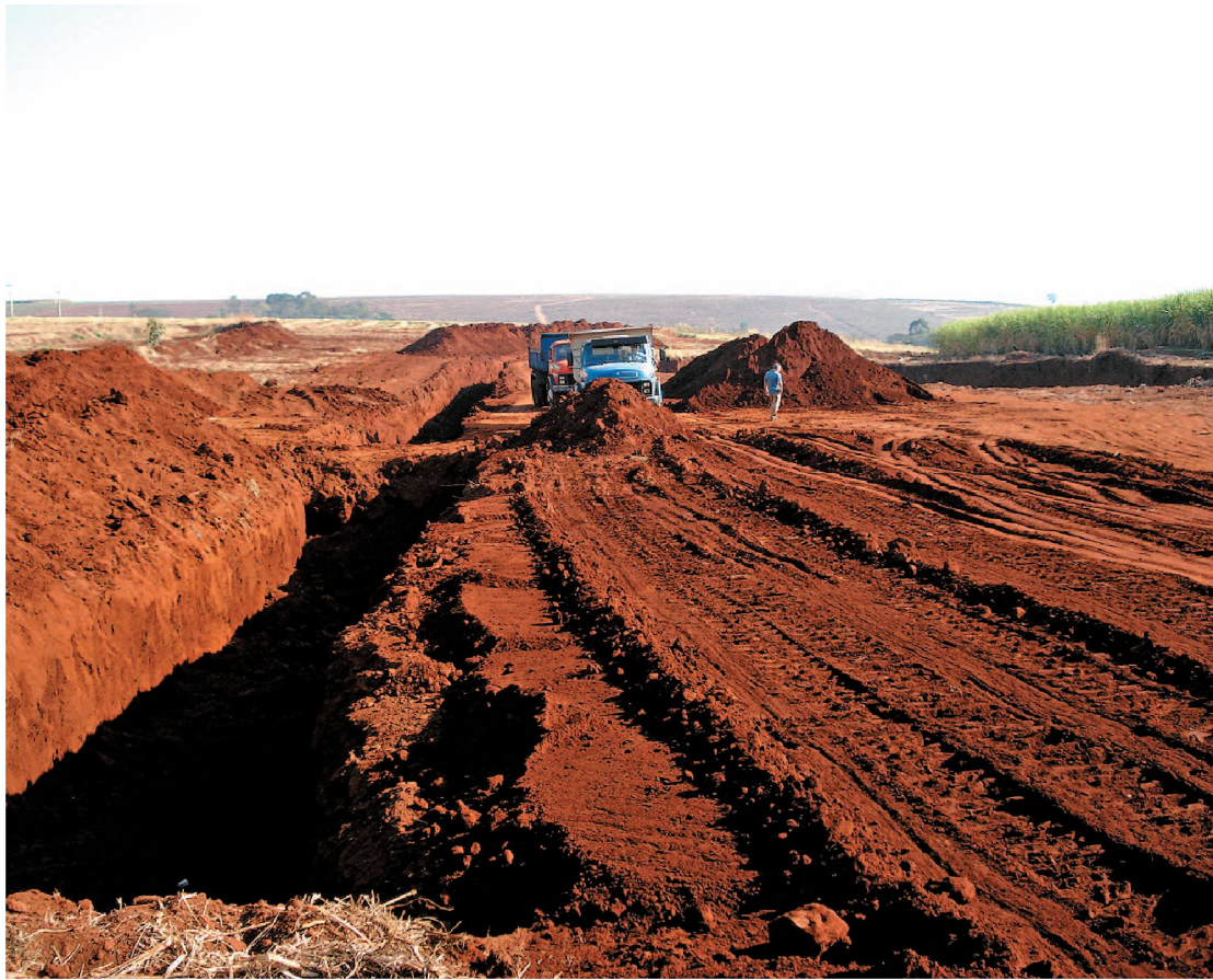
Obras executadas no "buraco da Aguinha" e que devem recolher o problema da erosão em definitivo
