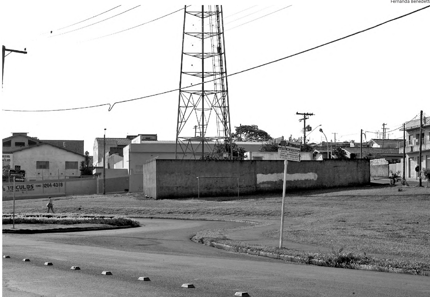
Vista geral do local onde será construída a base do Corpo de Bombeiros de Lençóis Paulista; área pertence à Prefeitura
