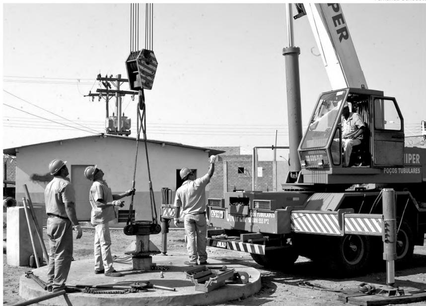
Empresa contratada pelo SAAE desmonta equipamentos do poço para verificação no interior
