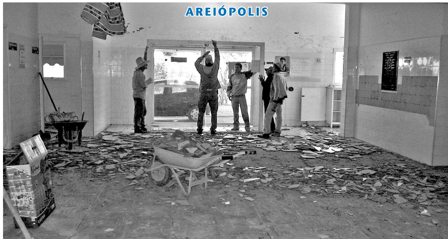
Operários trabalham na reforma das instalações da unidade mista de saúde, que vai receber novo piso, pintura e móveis
