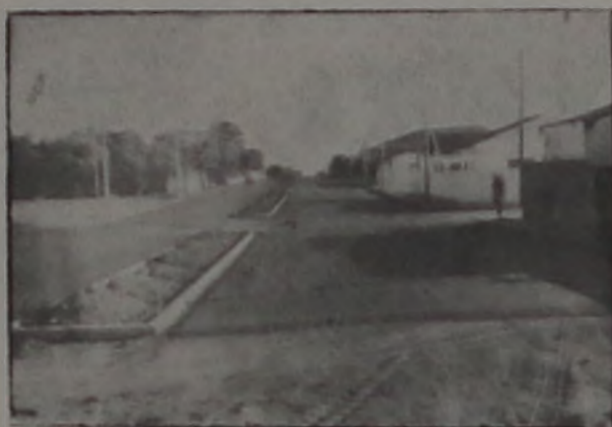
Av. Castelo Branco: faz tanto tempo que os moradores da Ubirama querem a conclusão da pavimentação desta avenida que eles nem conseguem acreditar! Mas é verdade, o governo do município fez!
