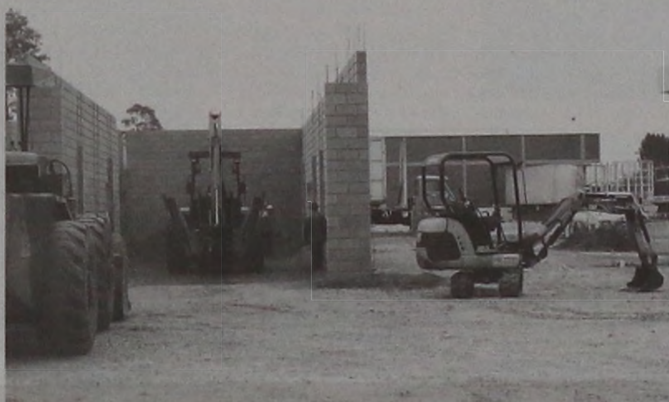
Posto 295 passa por reforma para receber cilindros de gás no mês que vem
