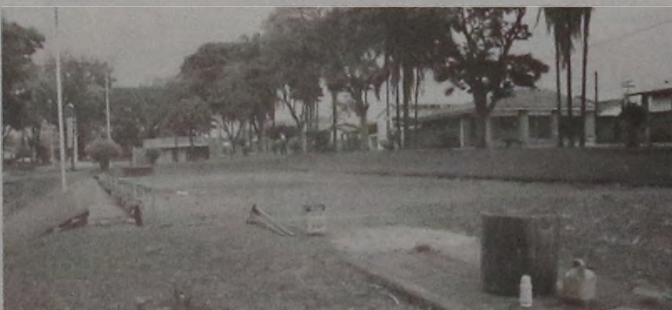
Reforma da praça deve ser concluída em 60 dias
