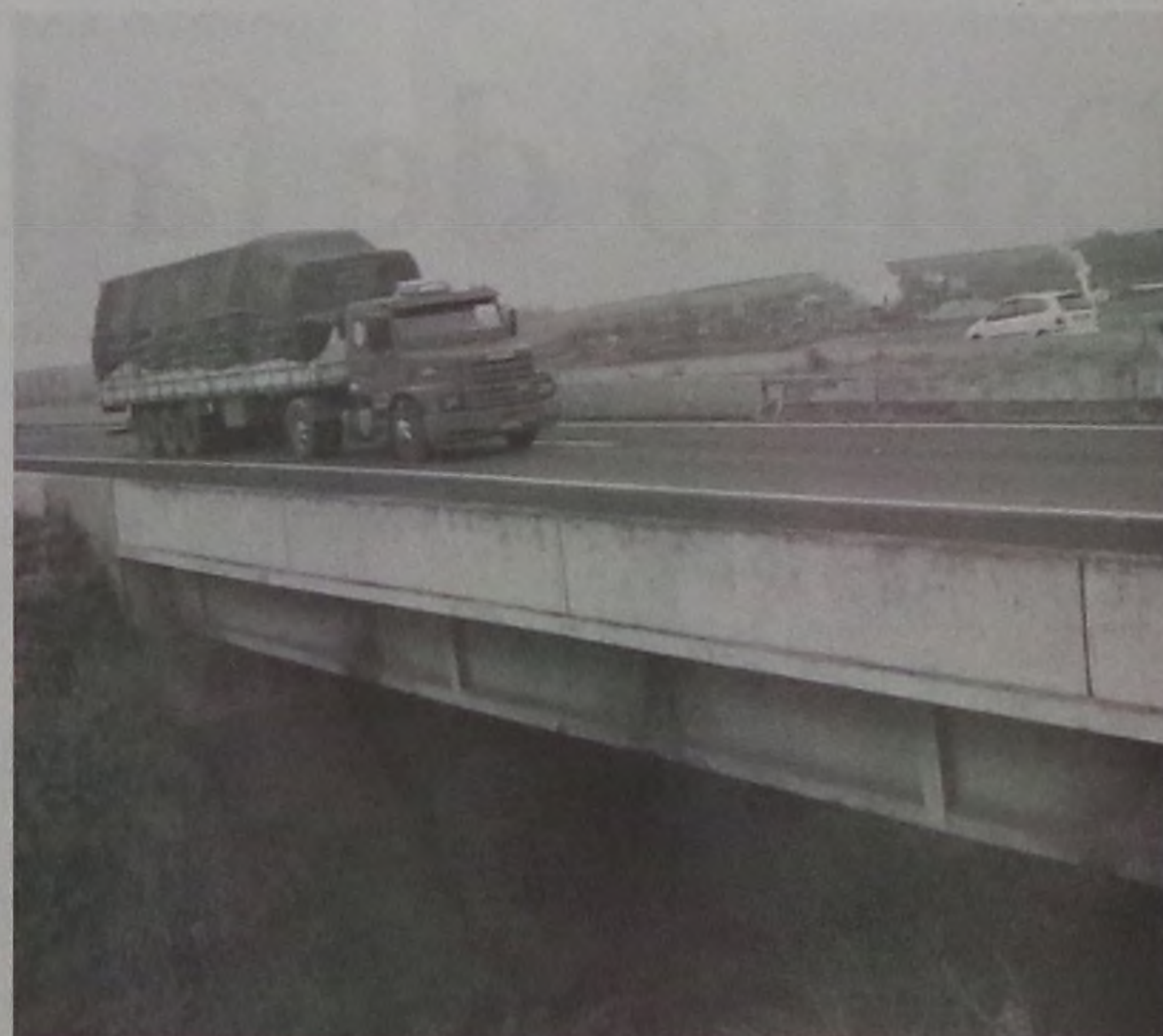
Região da Rondon onde vai ser instalada a alça de acesso, na altura da Fazenda Progresso
