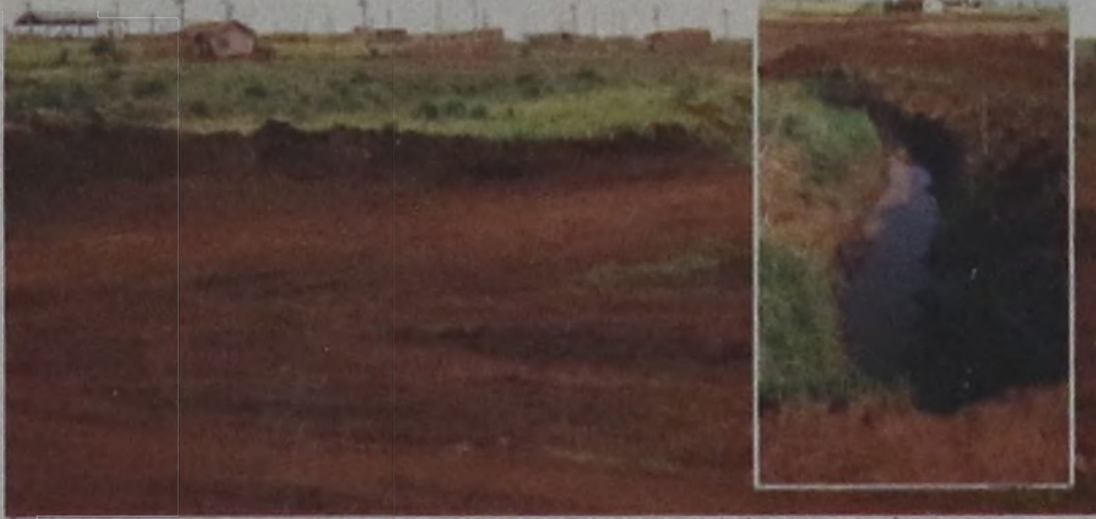
Área em que a erosão foi solucionada em foto tirada ontem, ao lado, a mesma área que era consumida pelo buraco em agosto de 2006; custo total da obra foi de R$ 200 mil
