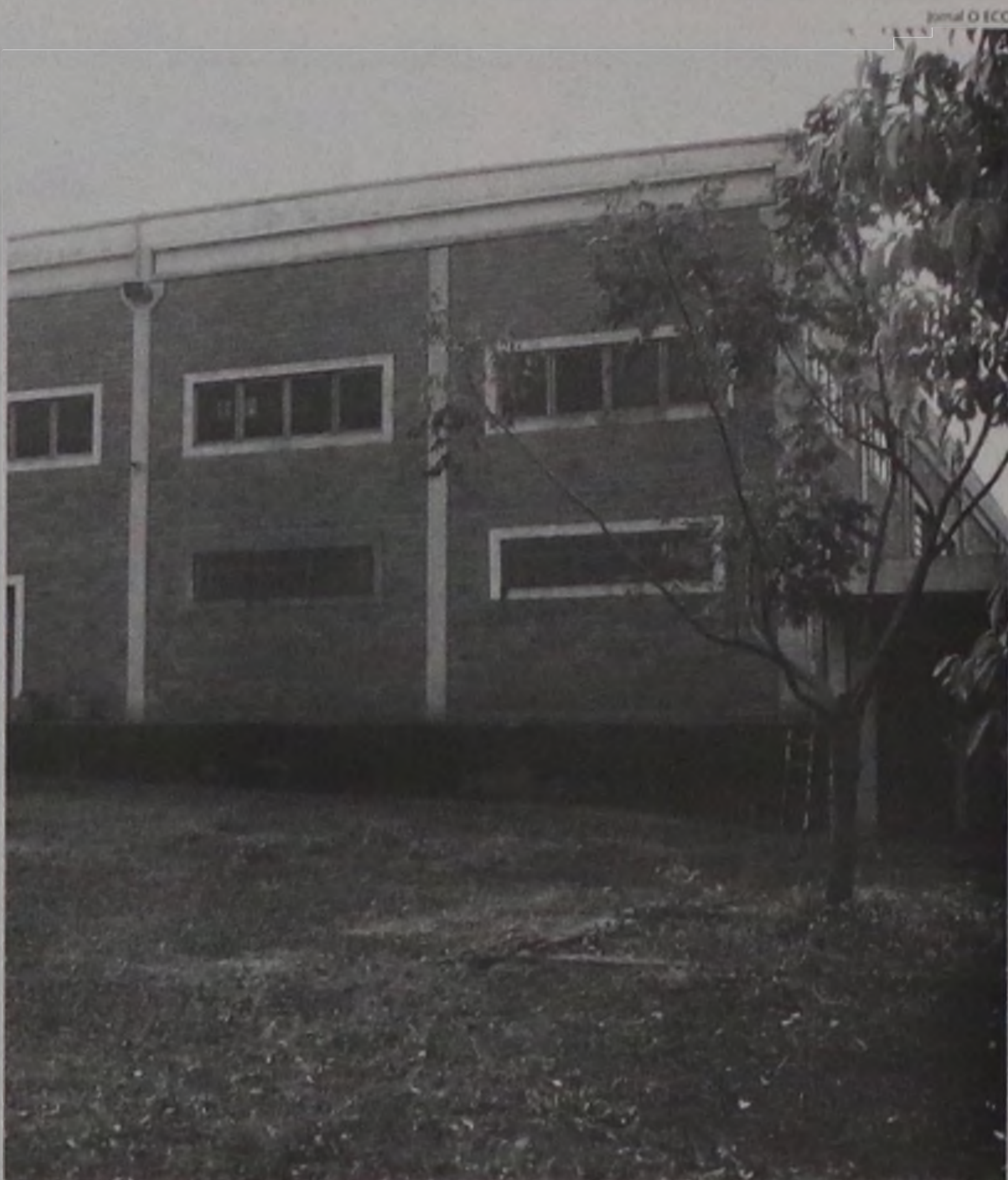
Prédio da antiga fábrica de doces Tagarella, às margens da Rondon, onde deve ser instalada a Mirage II
