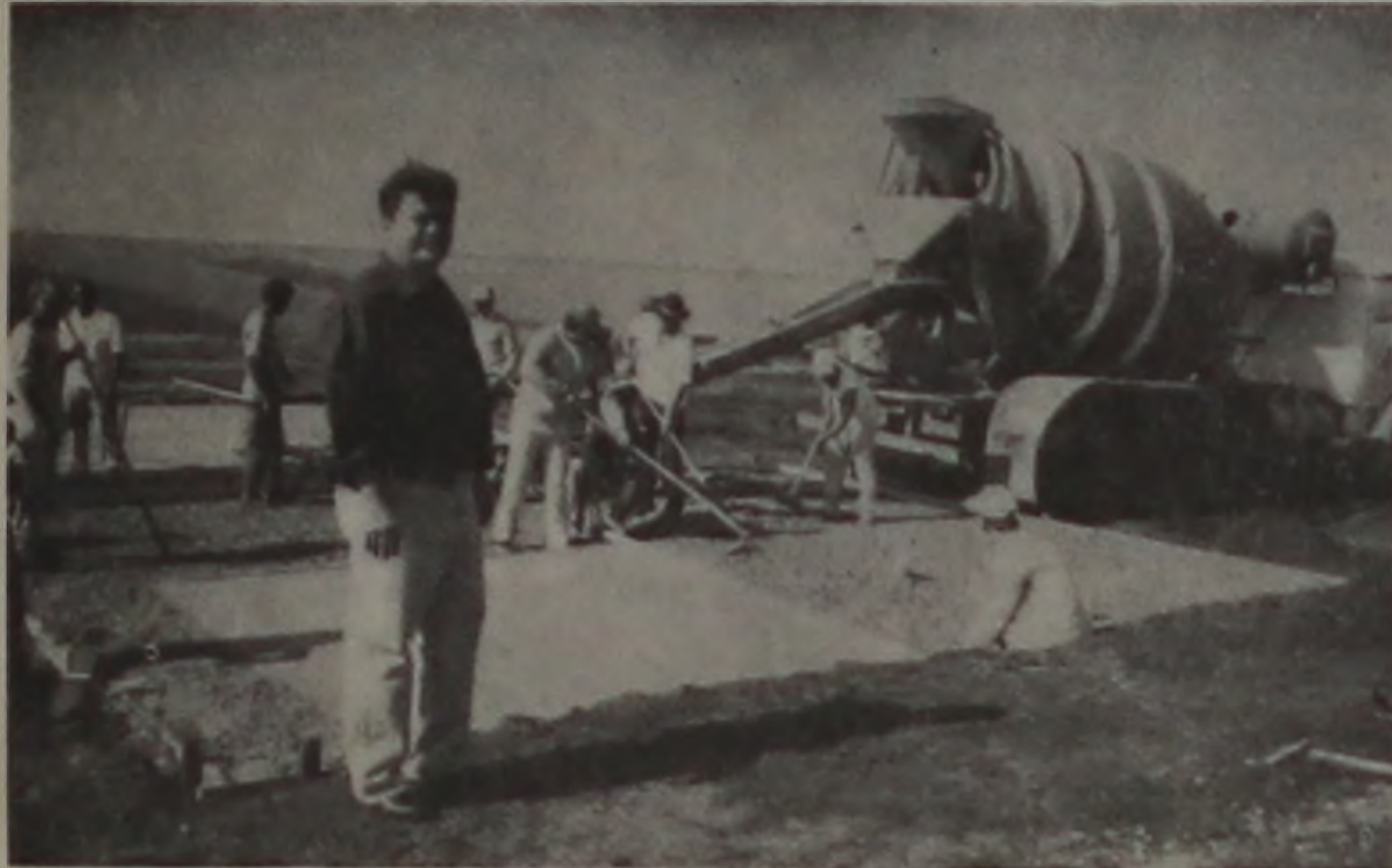
Prefeito visita canteiro de obras do Caju II.
