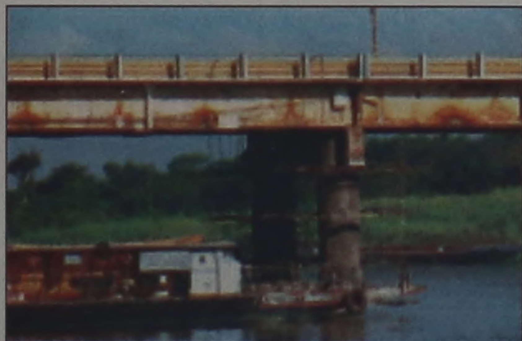
Ponte, ainda em reformas, pode ser interditada novamente nos próximos dias
