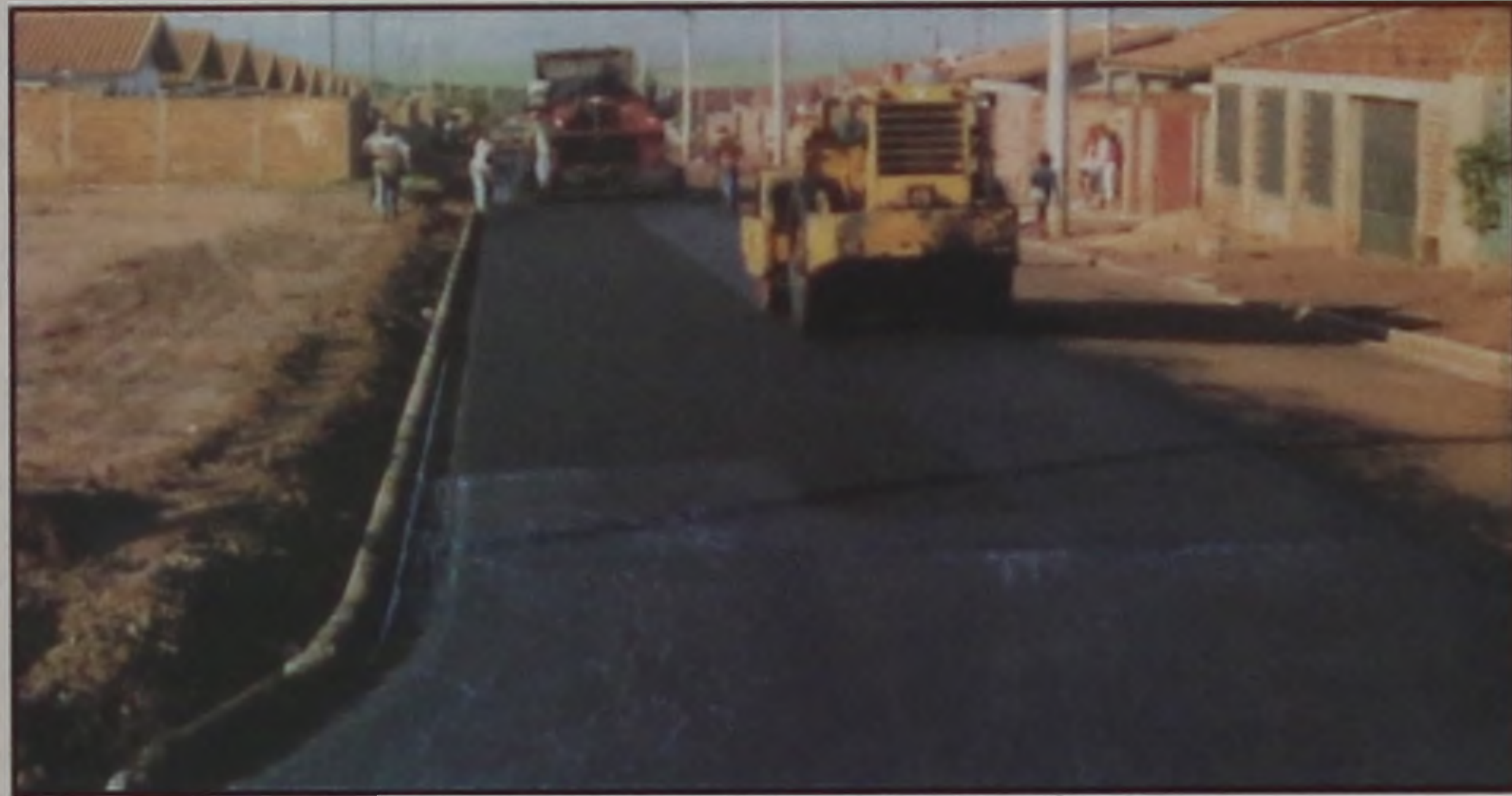
As obras de asfaltamento enquanto estavam em andamento
