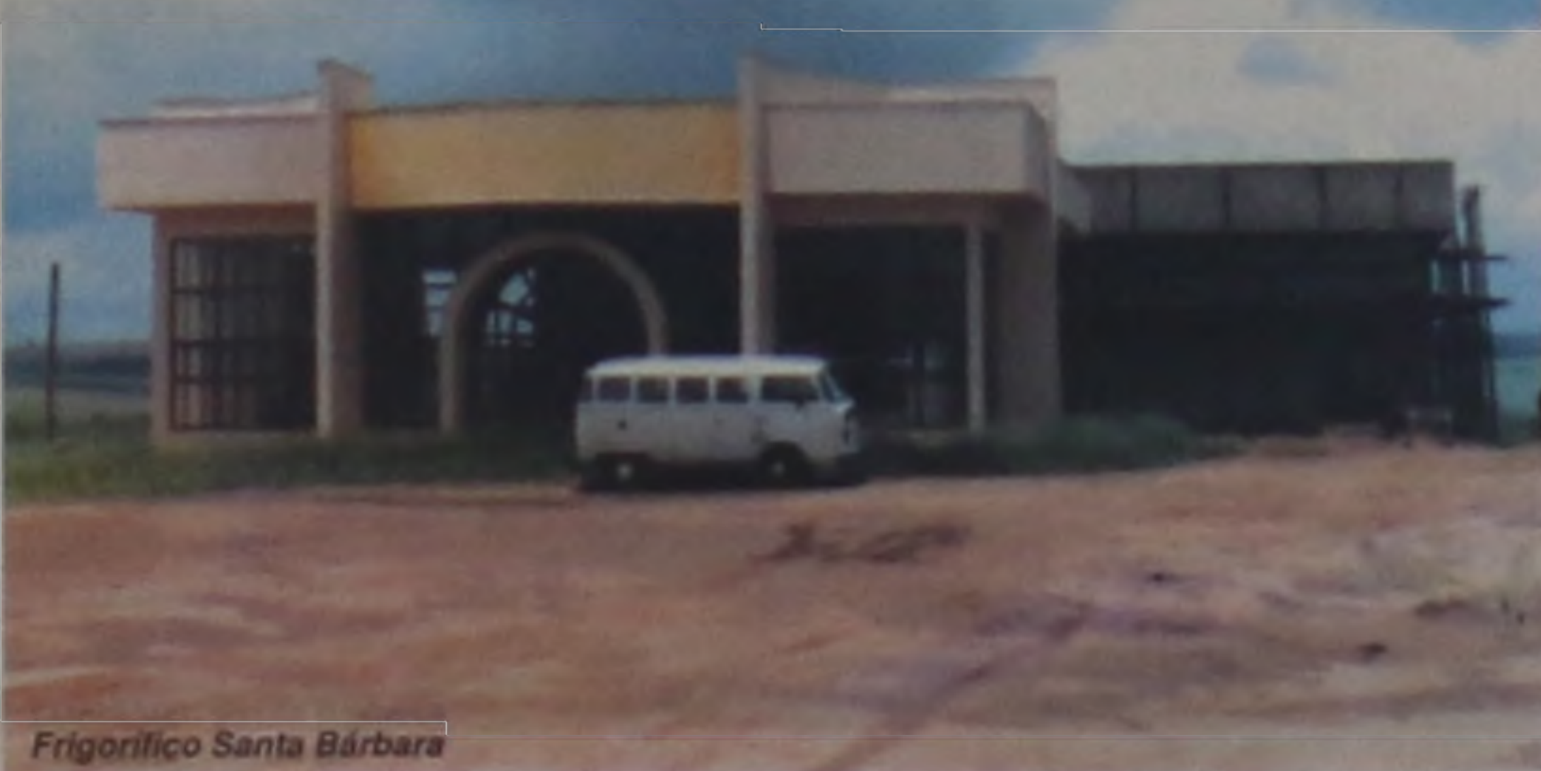
Frigorífico Santa Bárbara
