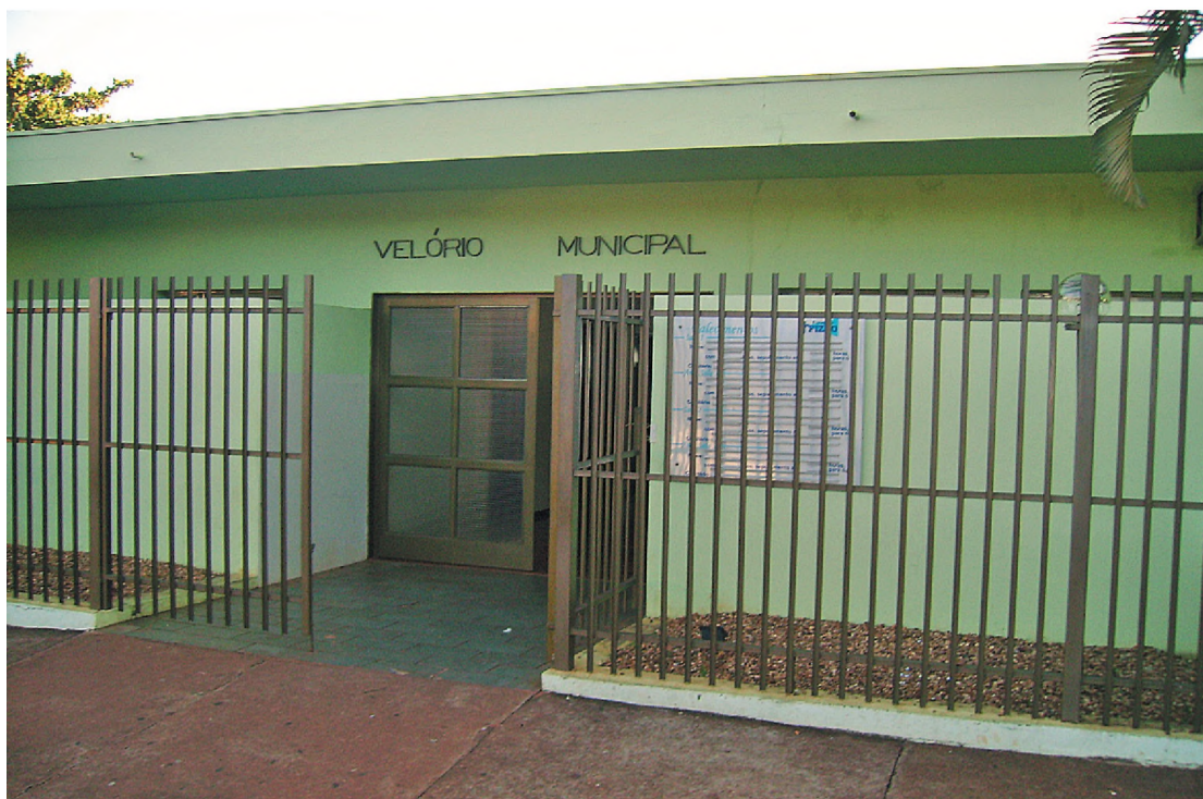
Fachada do velório municipal, onde foi protagonizada a briga entre funerárias
