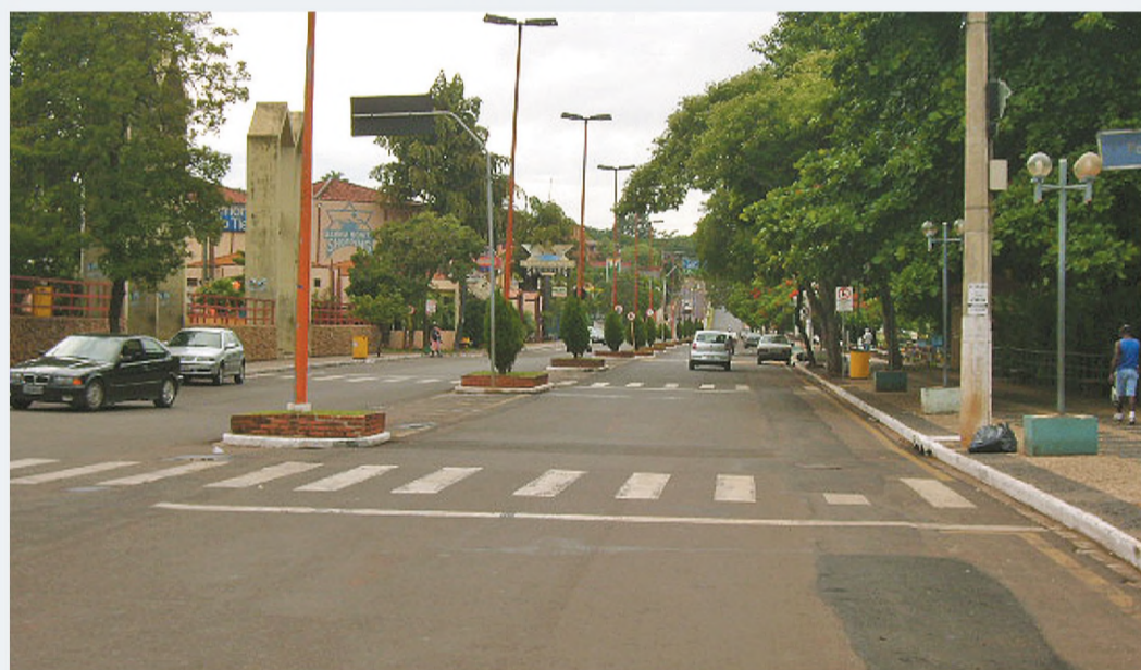
Vista geral da avenida Pedro Ometto, em Barra Bonita
