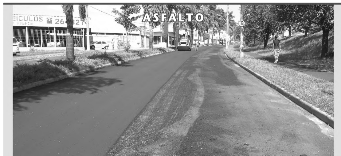
Concluído o recape da avenida Papa João Paulo II
