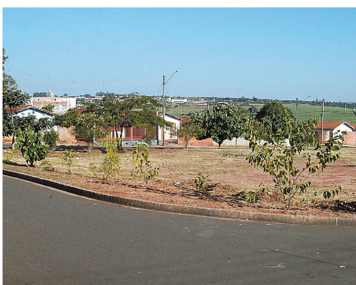
Área onde será construída praça esportiva no Júlio Ferrari
