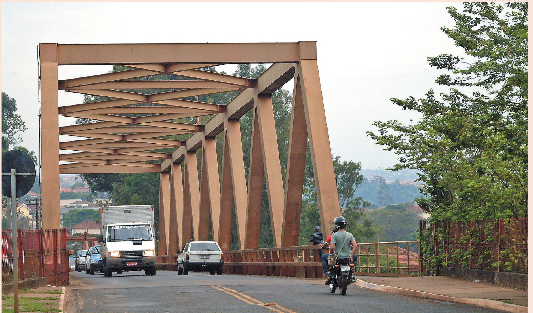
Tráfego de caminhões e ônibus na ponte Campos Salles, que liga Barra Bonita e Igarapu do Tietê, deve ser proibido; obra de 1915 está ameaçada pela corrosão
