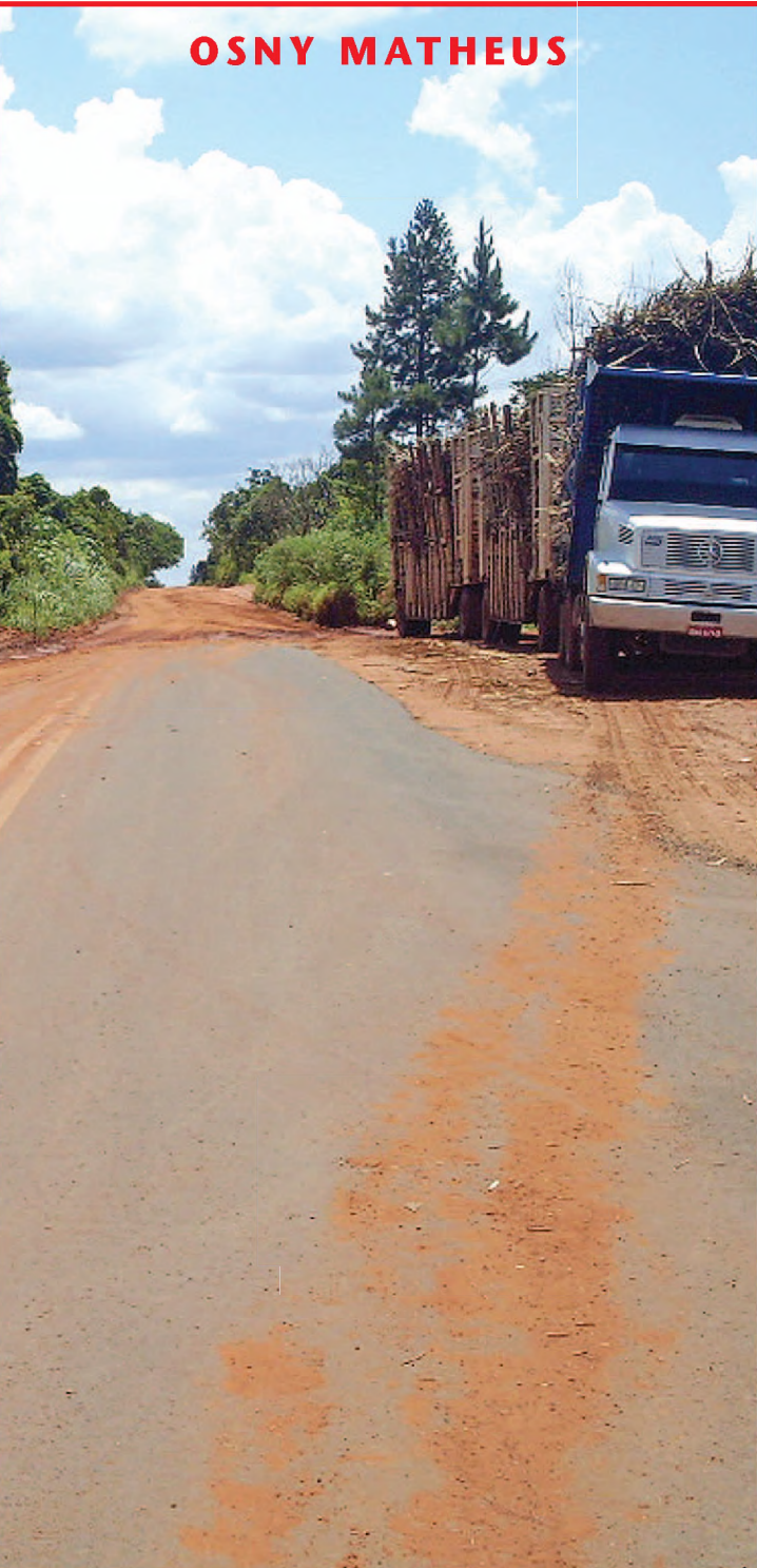
Asfalto da rodovia pode entrar no orçamento de 2009
