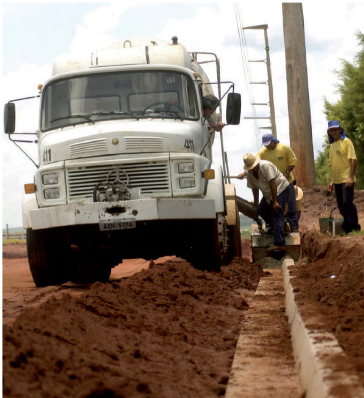
ASFALTO Com construção de guias, a Prefeitura de Lençóis Paulista dá início ao asfaltamento no prolongamento da avenida Prefeito Jácomo Nicolau Paccola até a rotatória de acesso à rodovia Marechal Rondon. A obra foi feita com recursos federais, estaduais e municipais.
