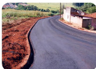
Asfalto em toda a cidade
