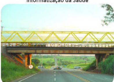
Passarela na SP 261
