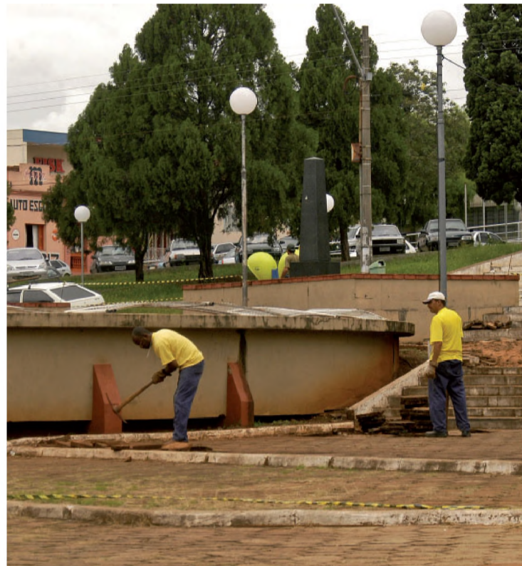
CONCHA ACÚSTICA Começou em janeiro a reforma da praça Comendador José Zillo, a Concha Acústica. Equipes da diretoria de Obras trabalharam na retirada do calçamento e na desmontagem do material que pode ser utilizado em outros pontos da cidade. A obra tem custo previsto para R$ 250 mil e foi concluída em julho.
