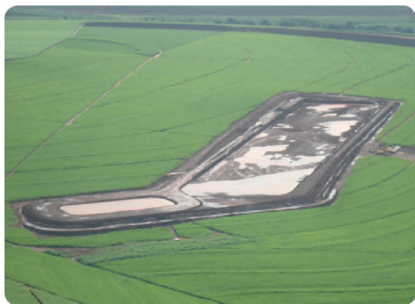
Estação de Tratamento de Esgotos
