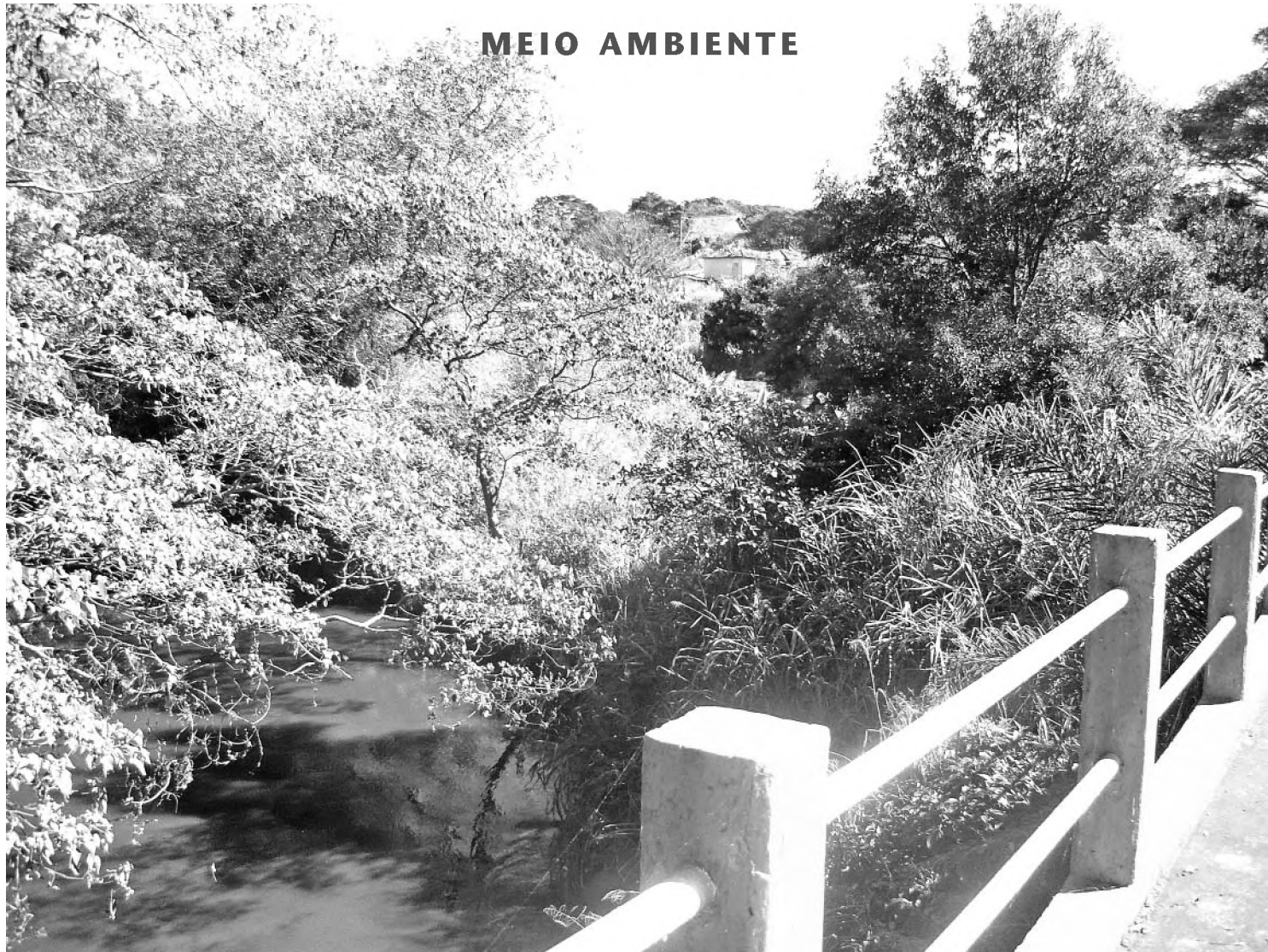
Área de Alfredo Guedes em que será construída a nova estação de tratamento de esgoto; projeto já foi aprovado
