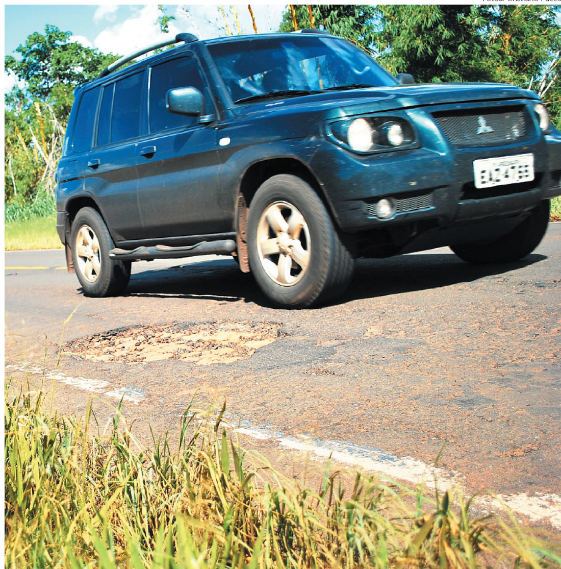
Depois da chuvarada, rodovia está cheia de buracos e põe a vida dos condutores em risco
