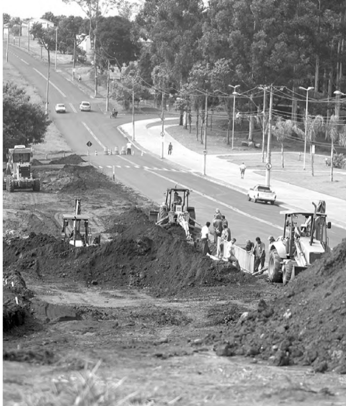
Troca de uma adutora fechou trânsito na Lázaro Brígido
