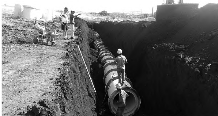
Tubulação que vai receber as águas de chuva já foram colocadas
