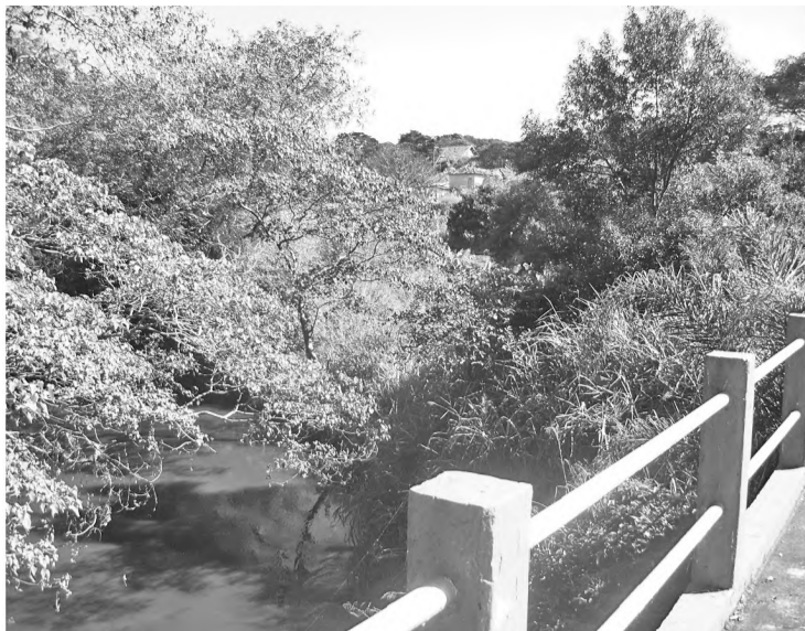
Área de Alfredo Guedes em que será construída a nova estação
