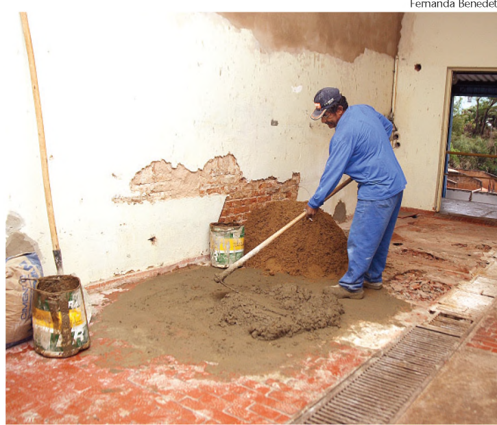
Reforma do prédio vai manter as características originais
