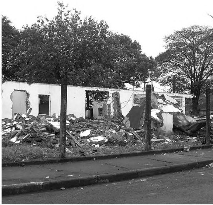
Antigo prédio da Assistência Social começa a ser demolido
