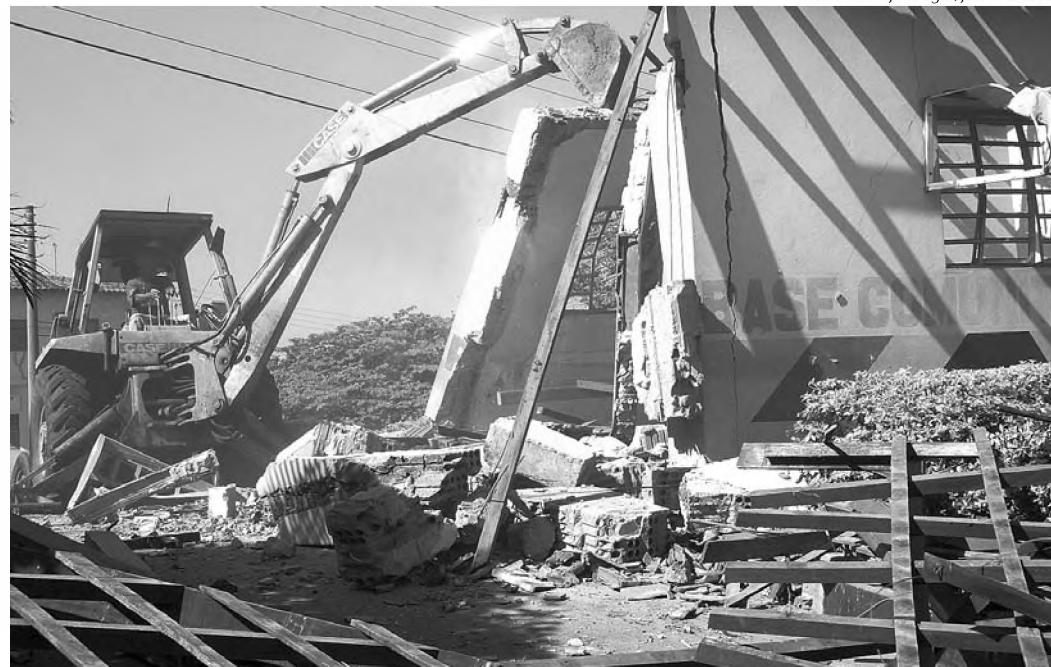
Retroscaavadeira trabalha na demolição da Base Comunitária da Cohab após atentados
