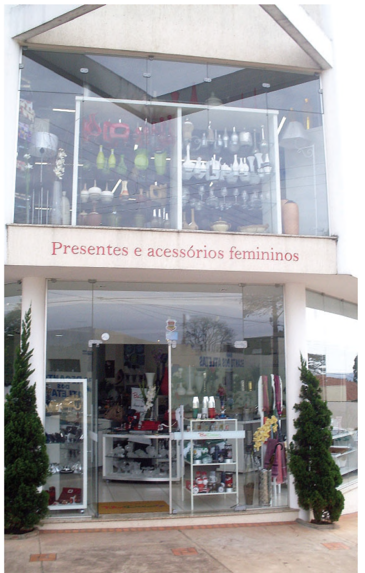
A loja, completamente remodelada, fica na rua 13 de Maio, em Lençóis
