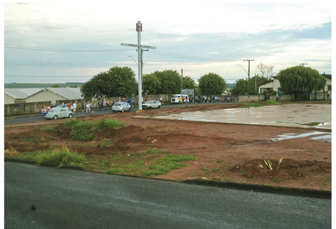
Obras na praça da Vila Cruzeiro estão paradas por falta de repasse de recursos federais
