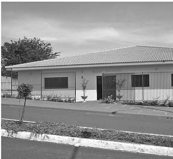
Vista externa da sede; trabalhos começam no mês de outubro
