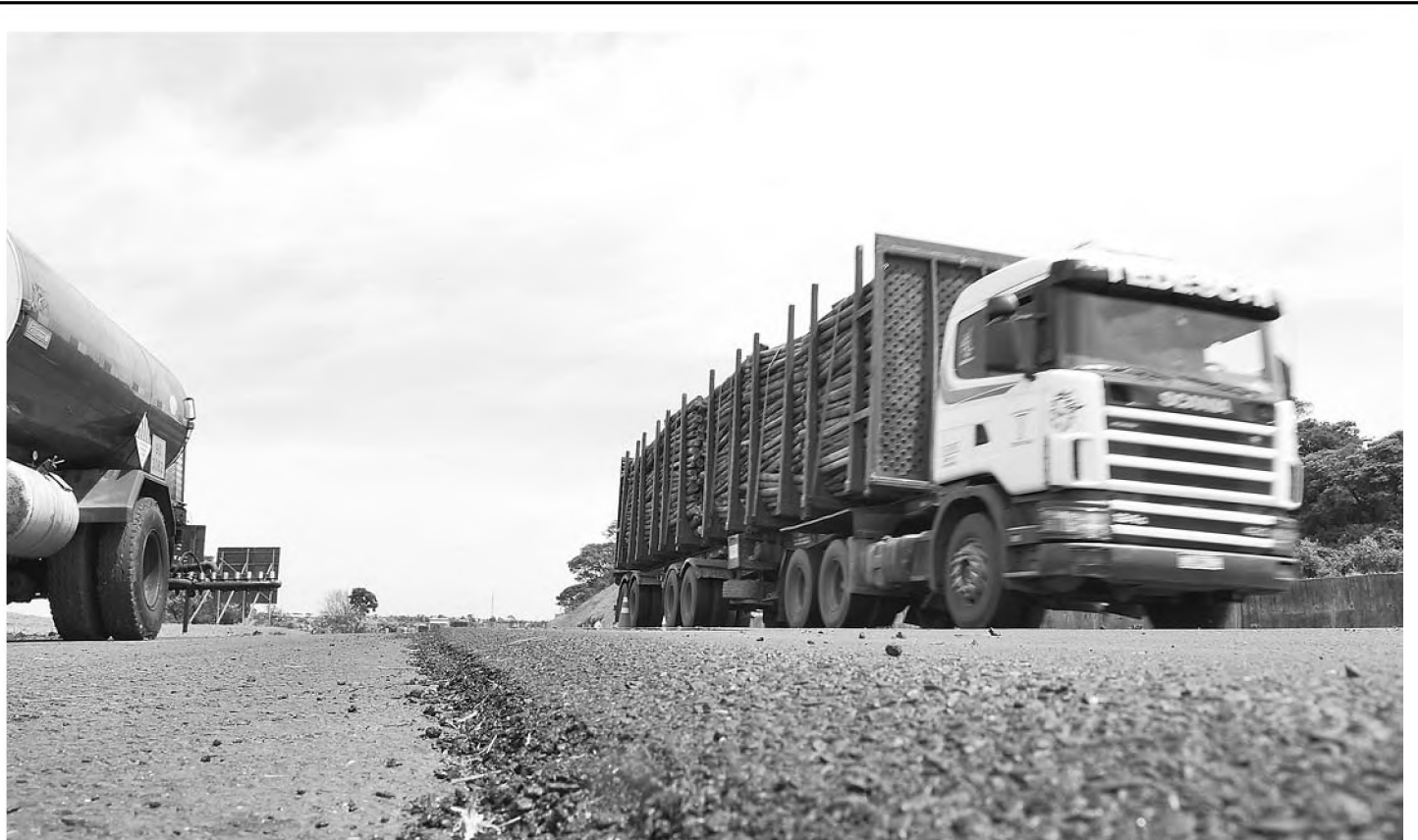
Recape na rodovia Marechal Rondon está deixando degraus na pista; concessionária Rodovias Tietê é quem administra
