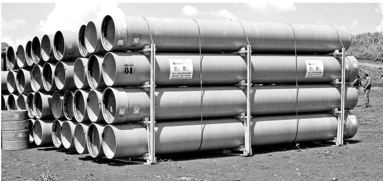
Emissário da Cachoeirinha será construído com tubos de fibra de vidro; córrego recebe esgoto de bairros na região do Caju
