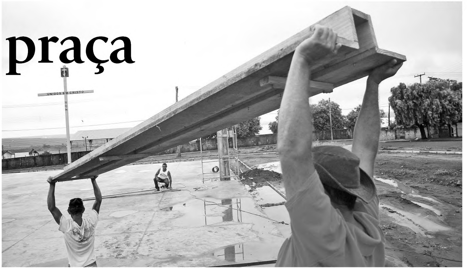
Essa semana, homens trabalharam na construção da praça na Vila Cruzeiro; outras duas obras foram retomadas na cidade
