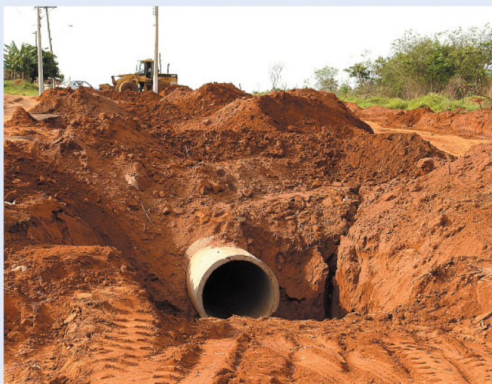
Obra para implantação de galeria no bairro Cidade Nova
