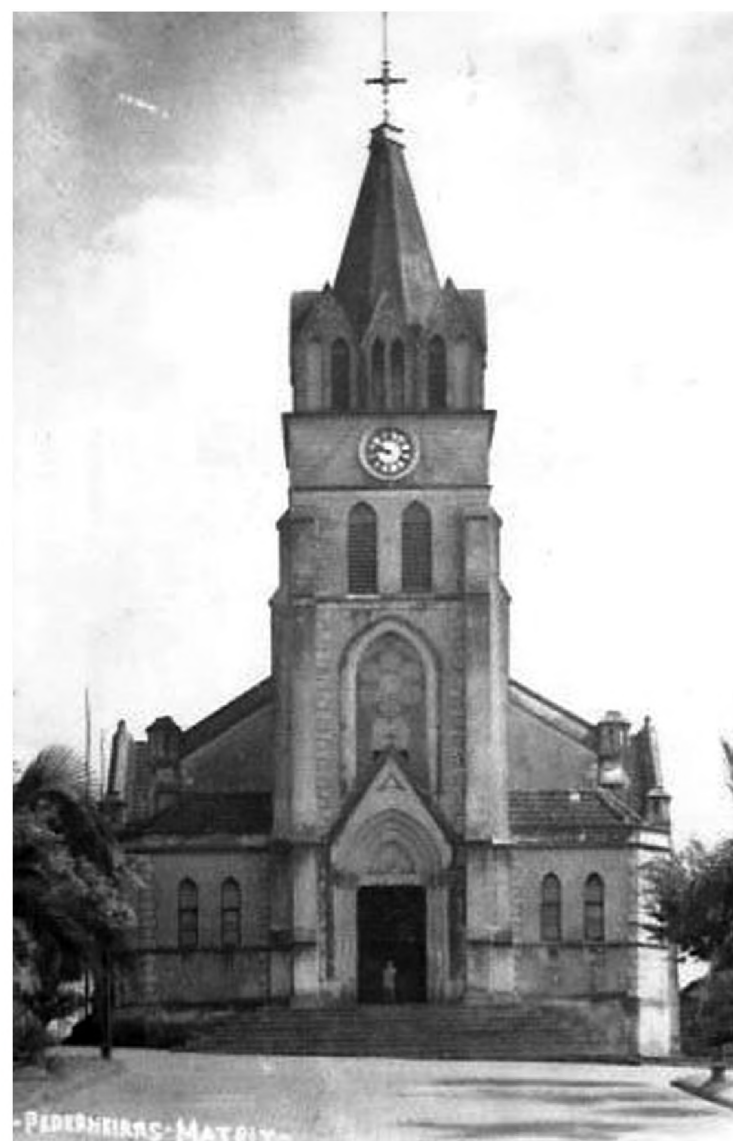
Imagem da antiga matriz, de 1931, antes da reconstrução
