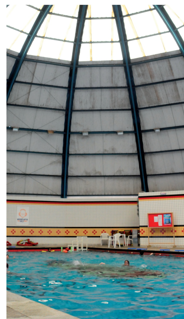
Estrutura da piscina aquecida
