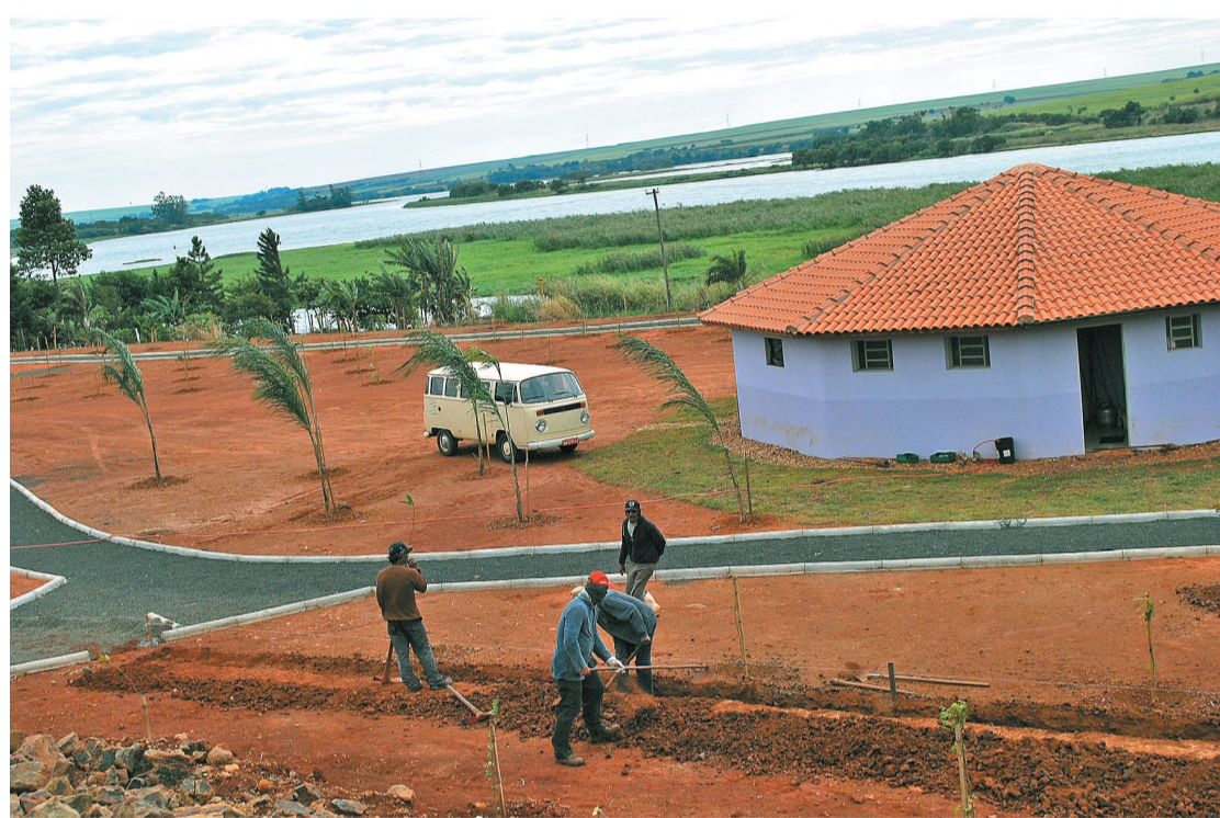
Funcionários trabalham duro para concluir o serviço até o dia 27 de junho
