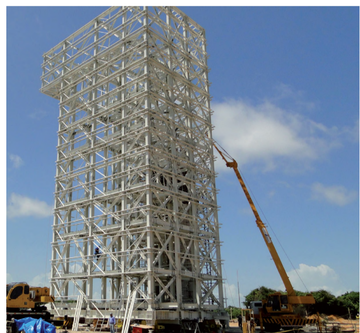
Base de lançamento de foguete no Maranhão: 33 metros de estruturas metálicas produzidas em Lençóis Paulista
